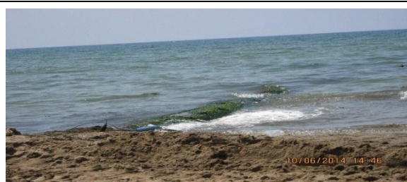
Figure II.09. Tuyau de captage de l'eau de mer
