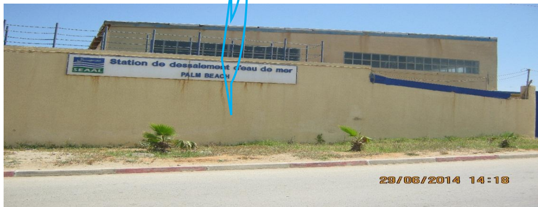
Figure II.07. Vue générale de la station de dessalement de Palm Beach
