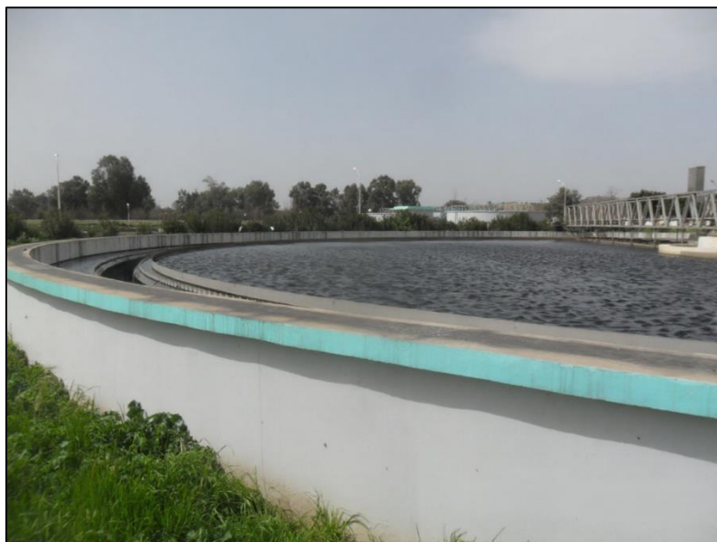
Figure 7 : Bassin clarificateur de la STEP de Chlef
