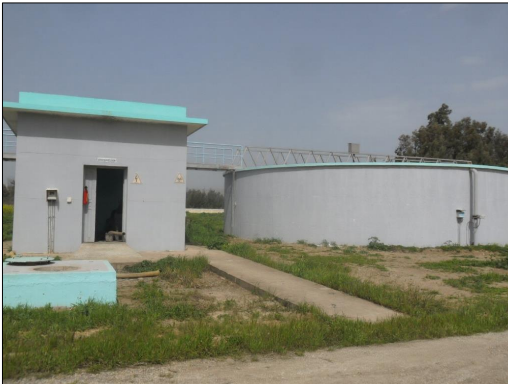
Figure 8 : l'épaississeur de la STEP de Chlef
