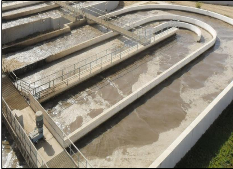
Figure 6: bassin d'aération de la STEP de Chlef
