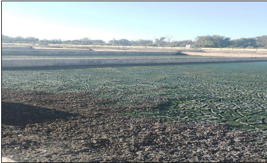
Figure 9 :lit de séchage de la STEP de Chlef
