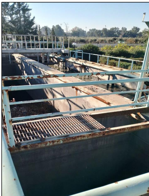
Figure 5 : Dessableur et déshuileur de la STEP de Chlef
