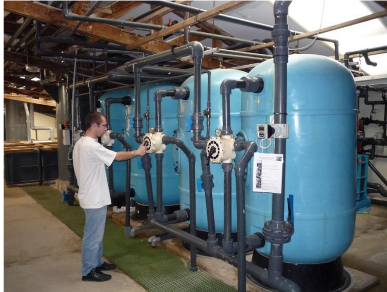
Figure I.7: Photo numérique d'un biofiltre à lit fluidisé ( www.aquaculture.ifremer.com )
