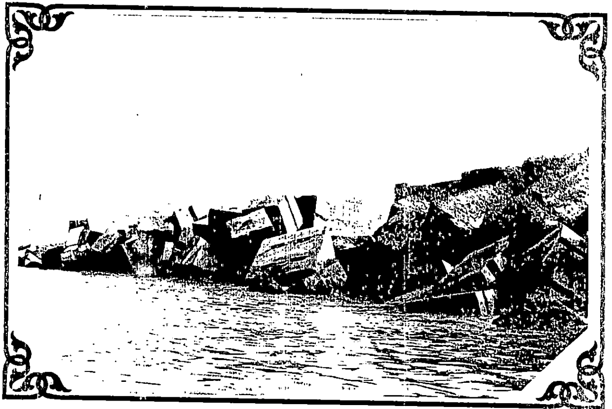
Photo 2 : Pose de blocs d'encrochements et de blocs cubiques.
