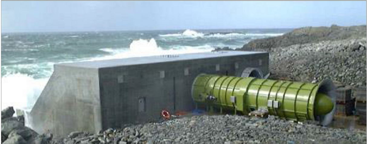
Figure I-9. Installation LIMPET OWC, d'une puissance nominale de 500 kW, installée depuis 2000 sur l'île d'Islay, Ecosse, Royaume-Uni
