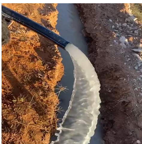
Figure 9 : Débit d'eau issu du forage 2(Photo personnelle,2024)
