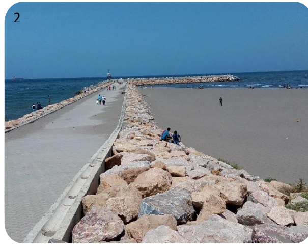
Photo 1-2-3 : Travaux élaborés des aménagements le long de l'embouchure d'Oued El Harrach (1), épis en forme de L coté Est de Sablettes (2), en (3) construction du terreplein coté centre de Sablettes.
