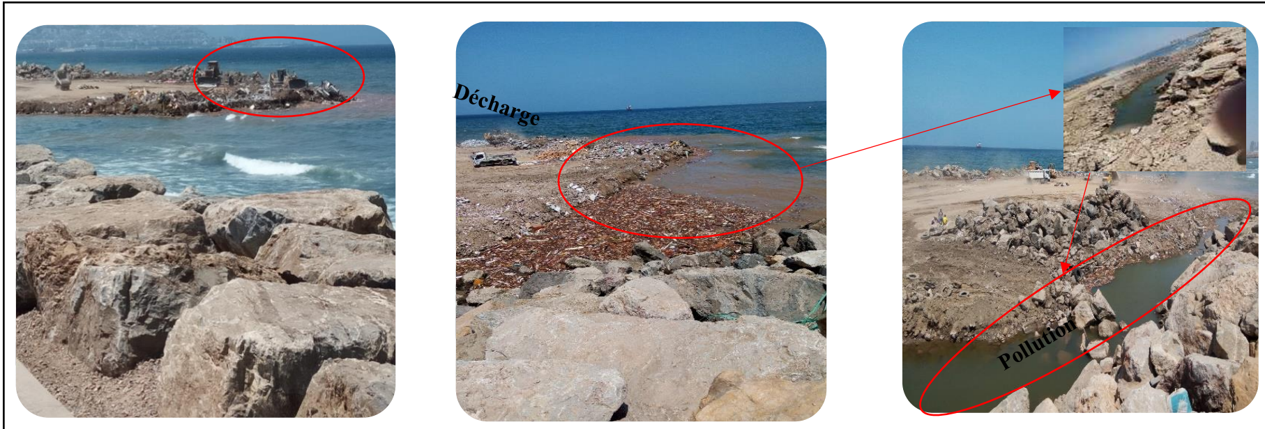
Photo7- 8-9 : Prise de vue du côté Centre des Sablettes, décharges des différents surplus de constructions en (8), le devenus des eaux après la décharges en (9).
