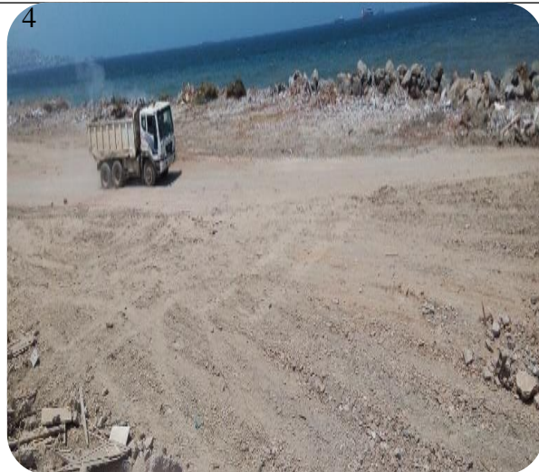
Photos 4-5-6 : Prise de vue du coté centre de Sablettes, construction du terreplein.
