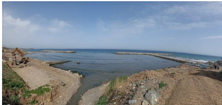
Figure I.17 : vue panoramique montrant le Birse-lames (avec formation de tombolo) et de l’épi dans la zone d’étude(Boualem et Dilmi,2021)
