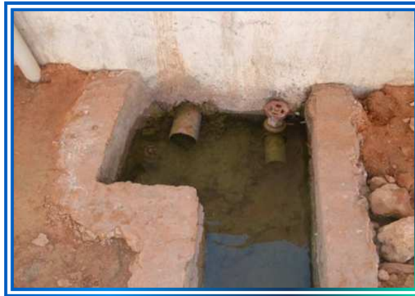
Figure II.35 : canal d'évacuation d'eau
