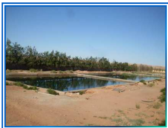
Figure II.16 : bassins de décantation
