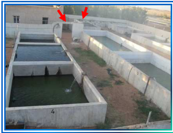
Figure II.5 : Entrées de l'écloserie
