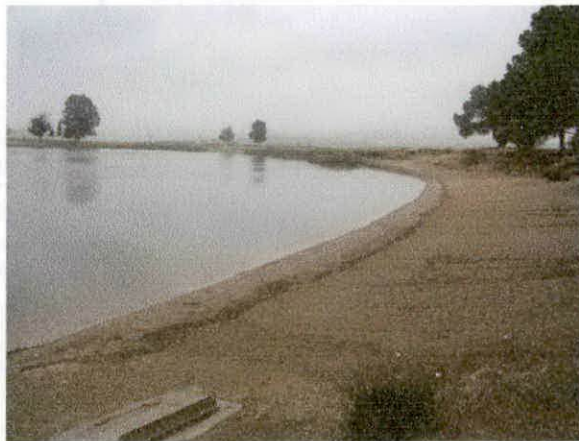
Figure 9 : Barrage de Bani Bahdel
