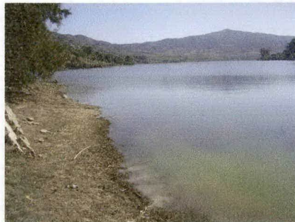
Figure 11 : Retenue collinaire de Cap Djinet.
