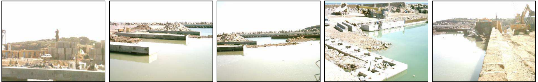
- Travaux de réaménagement du port de Tipaza -
