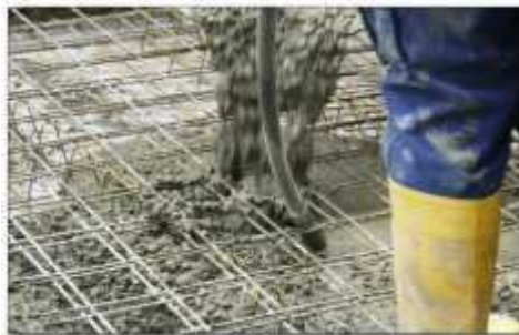
Figure n° 2: Béton armé (Rossi ,1998)
