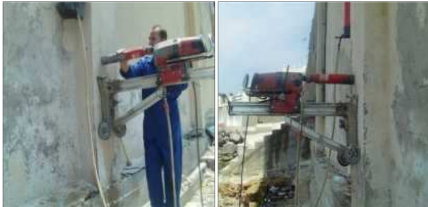
Figure n° 39: Prélèvement des carottes sur piliers
