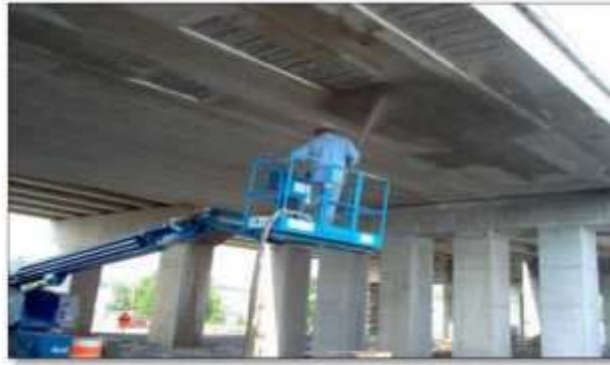
Figure n° 5: Répartition d'un pont grâce à l'utilisation d'un béton projeté
