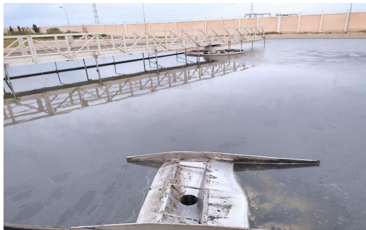
Figure VI 4 Décanteur primaire
