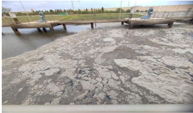
Figure VI 5 : bassin d'aération
