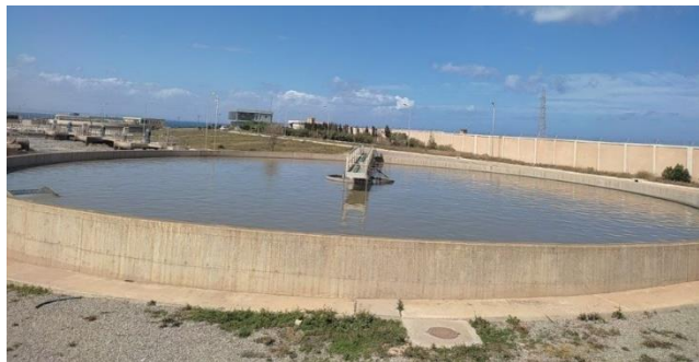
Figure VI 6 : clarificateur
