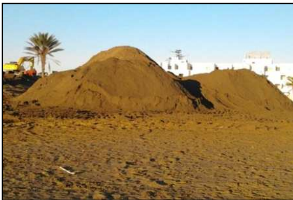
Figure n°V.05. Stockage du sable après dragage au niveau de la plage Est de Sidi Fredj
