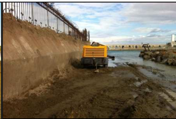
Figure n°V.06. Chenal d'accès (cavalier) pour le dragage de la passe d'entrée du port de Sidi Fredj.
