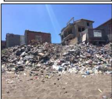
Construction sur le cordon dunaire et déversement des matériaux de construction
