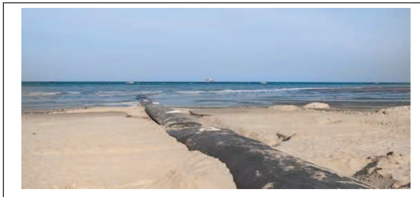
Figure 72 : Epi en géotextile (source: http://www.novintiss.com/fr/geotextile-anti-erosion.html )
