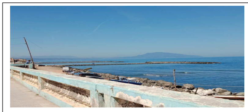
Figure 70 : Ouvrages de protection à Bou Ismail
