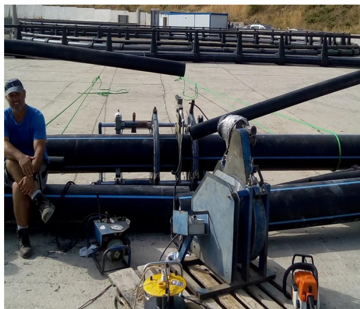
Figure III. 6. Le soudage final de deux extrémités de tuyau ; après ça soudage, le premier tuyau du collier de la cage est fermé (Sahraoui ,2019)
