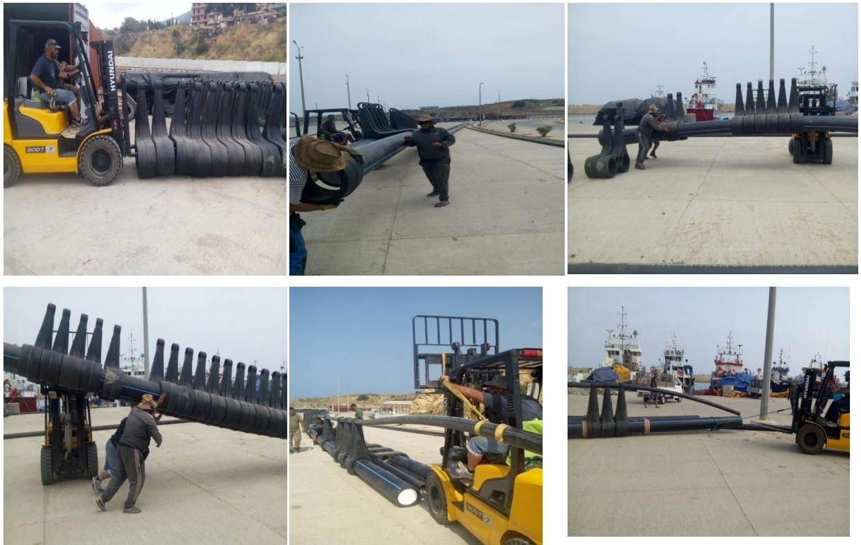
Figure II. 14. Les deux principaux tuyaux après leur construction ont déjà été insérés entre les chandeliers, qui sont répartis sur la longueur du tuyau et la main courante a également été insérée.(Sahraoui2019)
