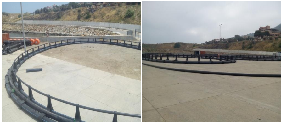
Figure III. 7. Structure finale du cerceau d'une cage sure terre (Sahraoui, 2019)
