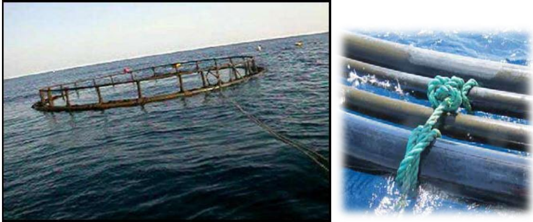
Figure II. 21. Remorquage des cages flottantes au site d'élevage (Ciattaglia, 2013)
