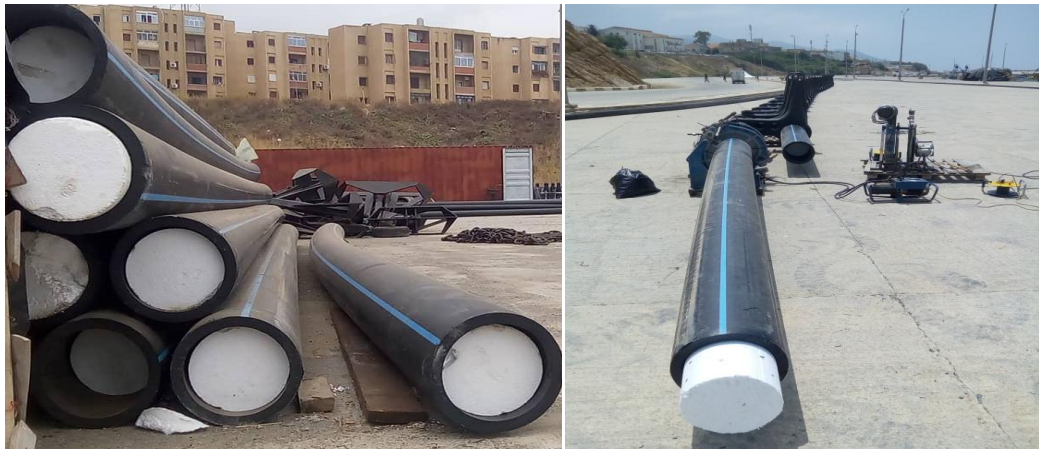
Figure II. 12. Détail de l'extrémité du tuyau: le cylindre en polystyrène est visible. (Saharaoui ,2019)
