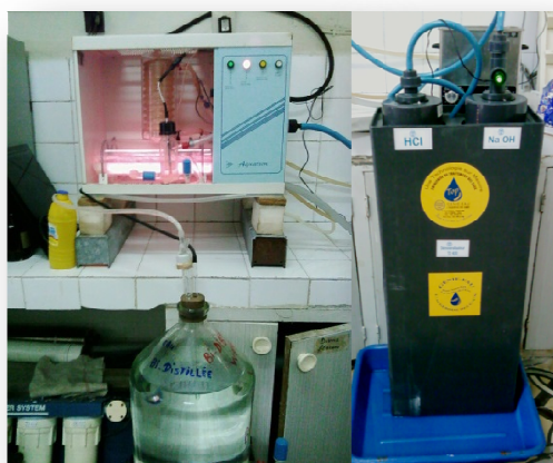
Figure 18. Distillateur couplé un déminéralisateur.
