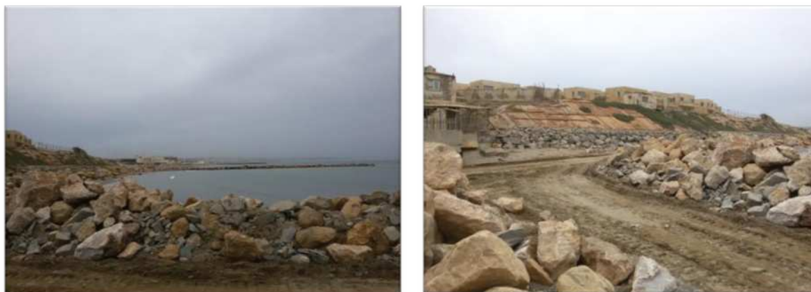
Figure (68) : Travaux pour construction de nouveaux épis au niveau d'Azur.
