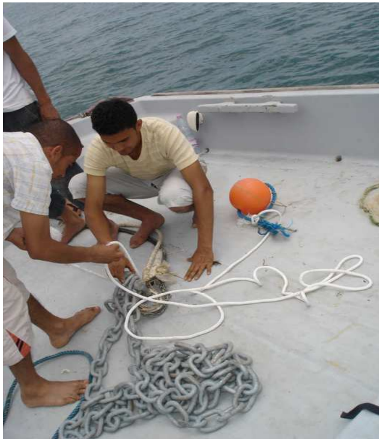
Figure 3: Amarrage des flotteurs et fixation de la chaîne sur les manilles.
