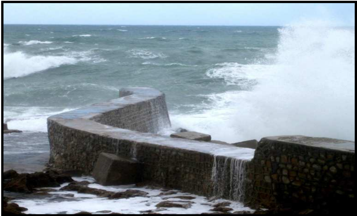
Photo 4 : Franchissements au niveau du musoir de la presqu'île (2007)
