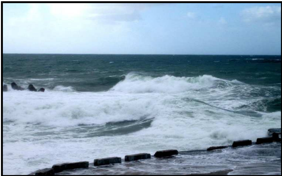
Photo 3 : Agitation au niveau de la passe d'entrée du port d'el kala lors d'une tempête (2007)
