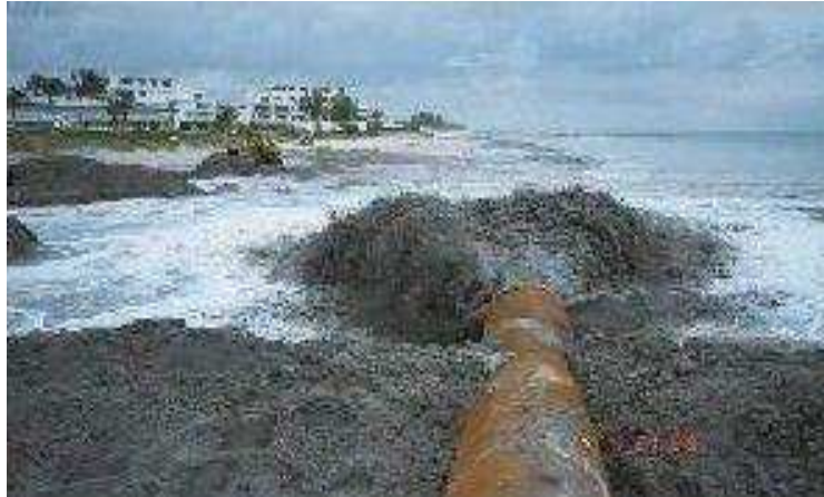
Figure IV-6: Matériaux répandus sur la plage par des conduites. (CoDISOD ; 2008).
