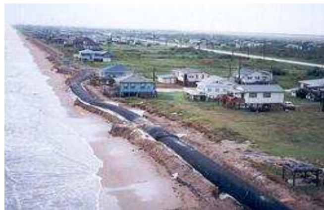
Figure IV-9 : Géotubes installés sur une plage.
