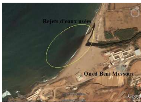
Figure V-4 : Rejets d'eaux usées sans traitement préalable.
