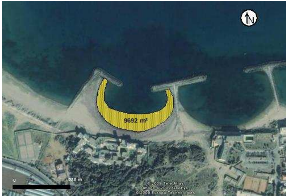
Figure IV-4 : Surface d'injection de la plage d'El Ryadh. (Aidoud, Mimouni ; 2009).
