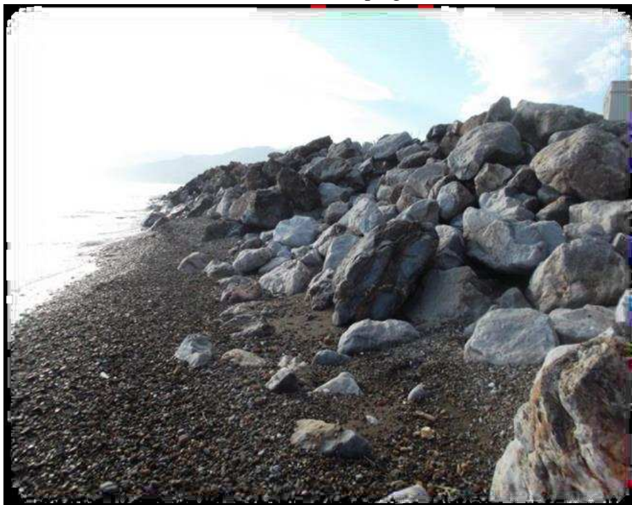
Photo n°02 : Protection en enrochements naturels de la plage.
