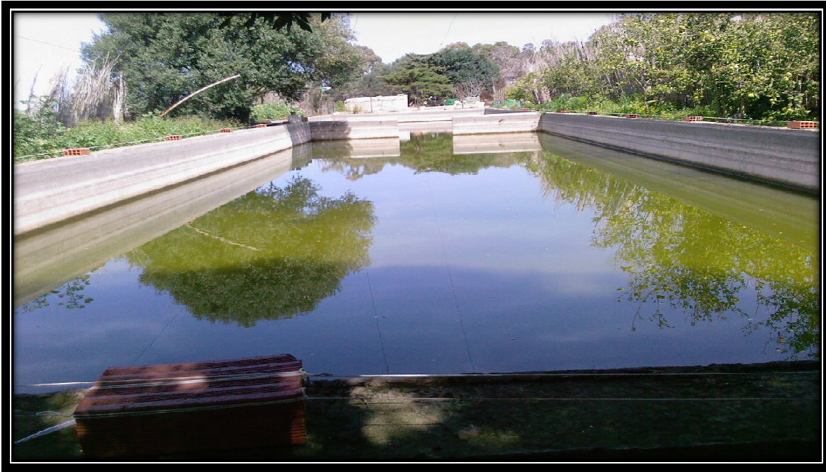
Fig.17 : Bassin de grossissement (Bouchaoui).
