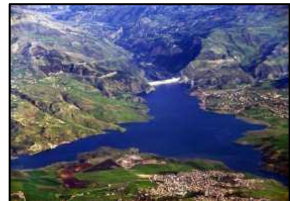
Photo n°8 : Barrage El Aghr
