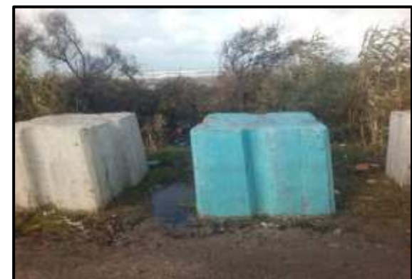
Photo n°6 : Blocs rainurés contre le pillage du sable
