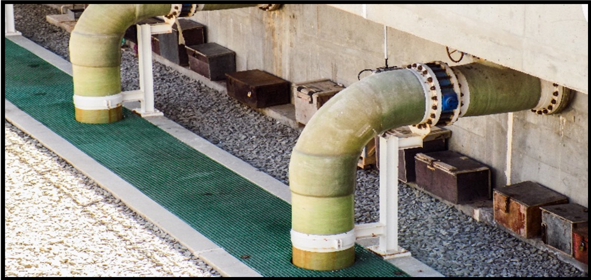
Figure 20: Filtre à sable
