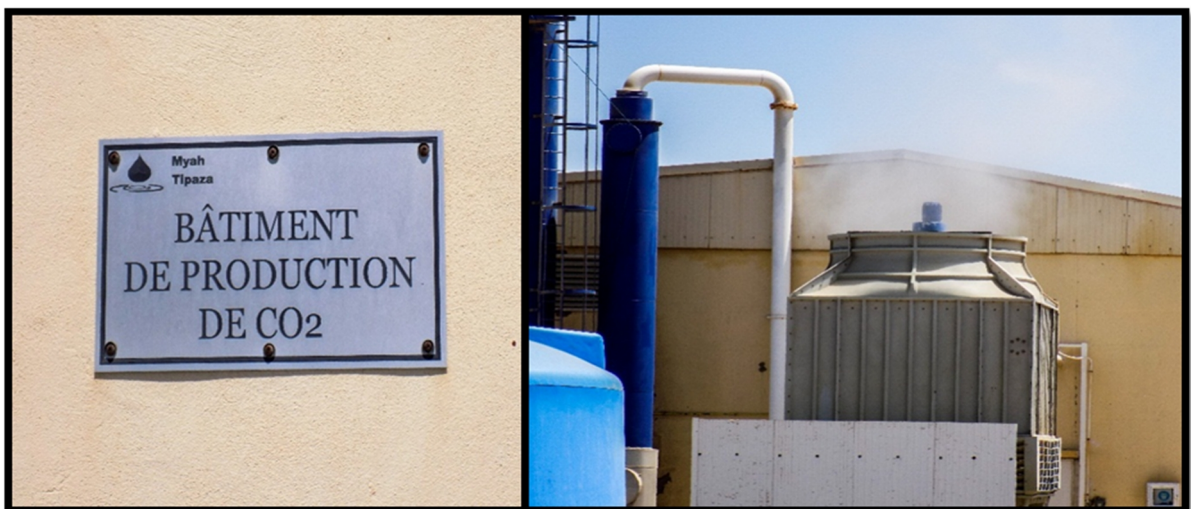
Figure 25 : bâtiment de production de co2
