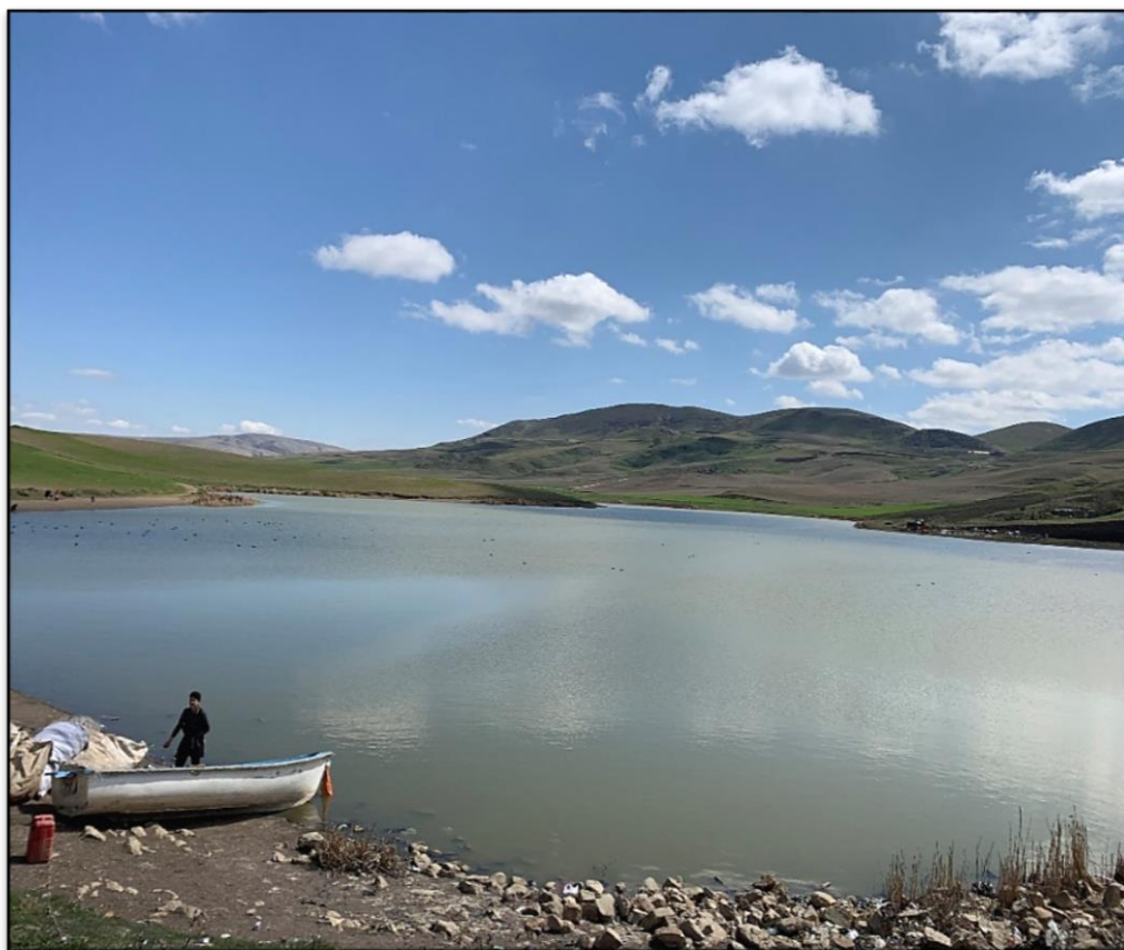
Figure 9 : Retenue collinaire de Zaïri (Sétif) (Écloserie de Zaïri, 2021)
