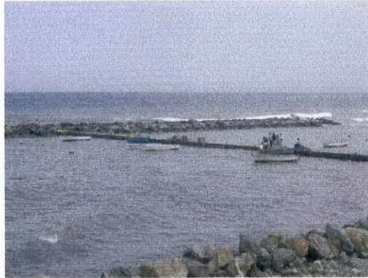
Photo.2. Brise-lame avec digue flottante
