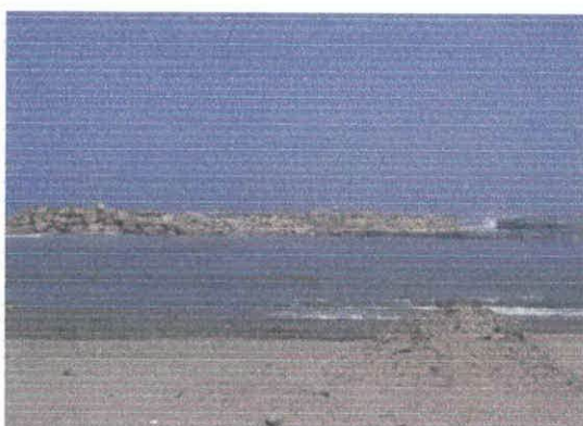
Photo.4. Vue d'un brise-lame
