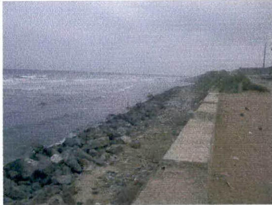
Photo.1. Le mur de soutènement
