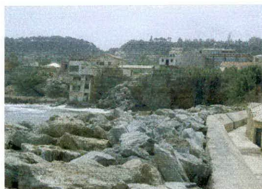
Photo.3. Les enrochements de la jetée Est
