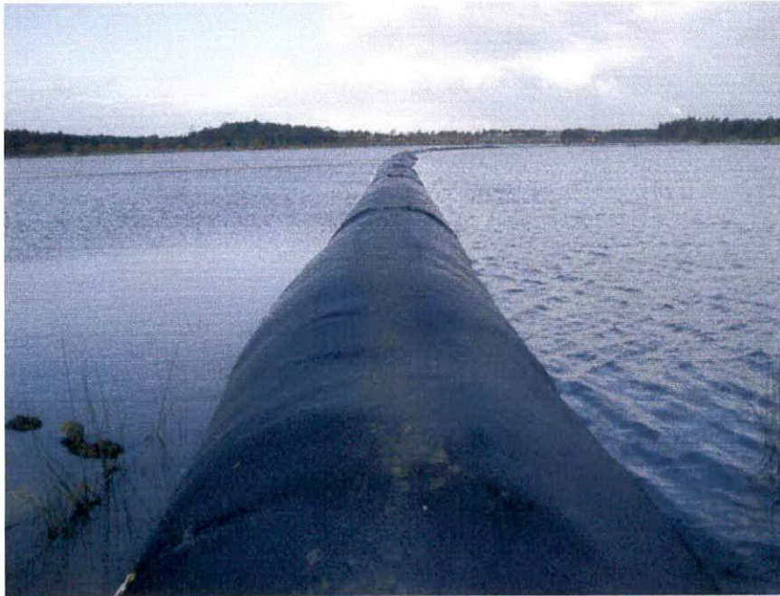
Photo.3. Positionnement d'un géotube en mer
