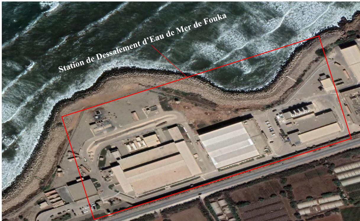
Figure II. 17 : Enrochement naturel pour la protection de la station de dessalement d'eau de mer de Fouka à Bou Ismail (SASplanet, 2022).
