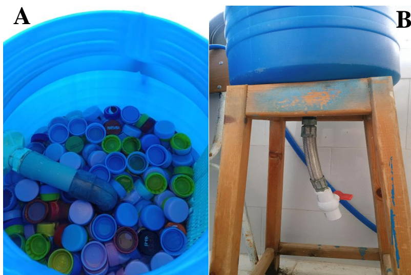
Figure 21 : Filtre biologique (A, Les bouchons du filtre. B, Robinet de vidange au fond du filtre)
