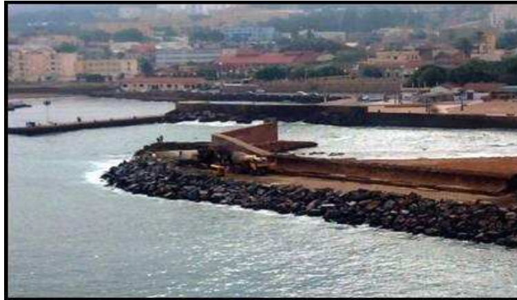
Fig II-5: Protection de la falaise. (DTP Tipaza)
