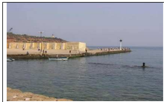
Fig II-7: Photo du quai Nord du port de Tipaza.
