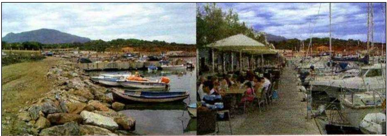
Fig II-26: Photo avant/après aménagement des quais. (DTP, 2009)
