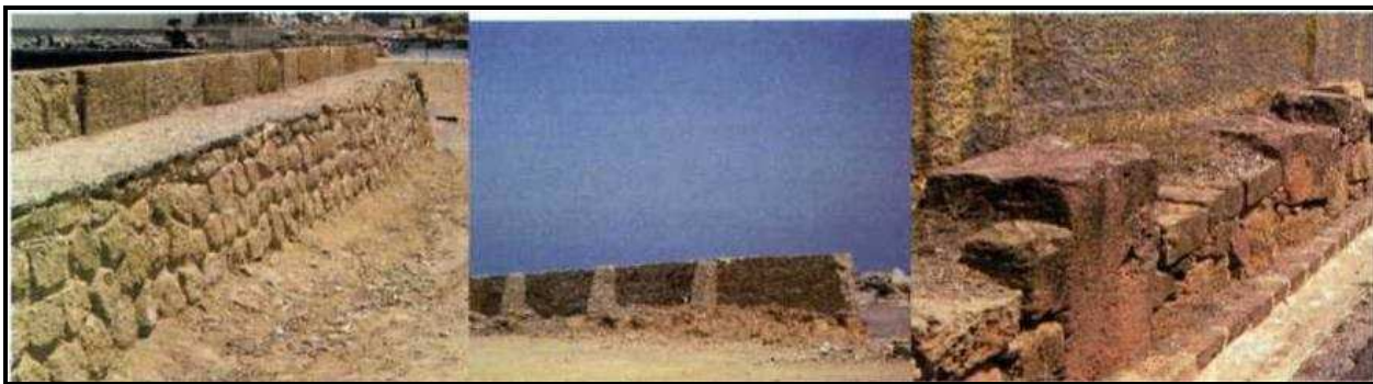
Fig IV-2 : Réseau de petits murets en pierre sur le port de Tipaza (DTP de Tipaza)
