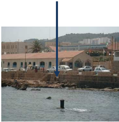
Fig IV-3: Rejet des eaux usées dans le port de Tipaza.
