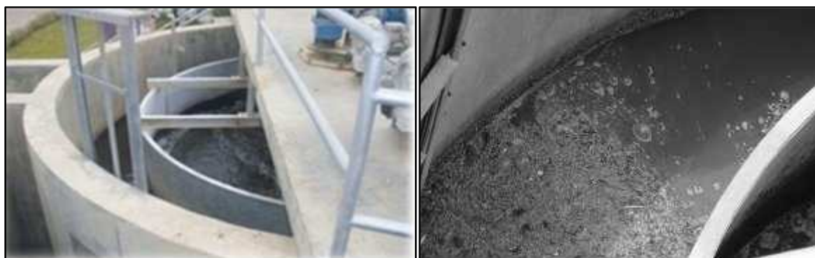
Figure IV.5 : Dessablage - déshuilage
