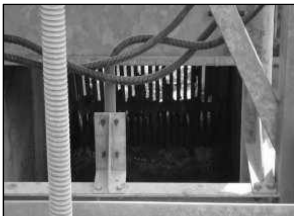
Figure IV.4 : Dégrilleur grossier
