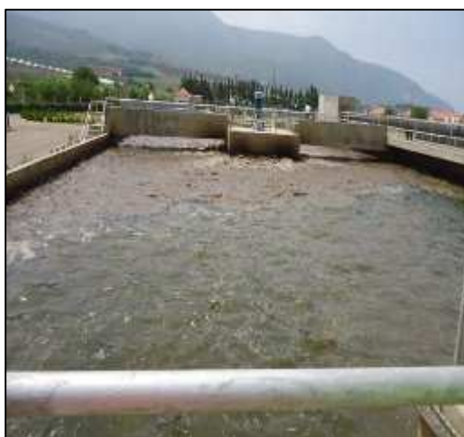
Figure IV.7 : bassin d'aération
