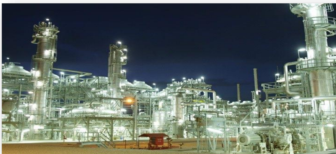
Figure I.10 : Vue du complexe gazier CPF d'Ohanet [13]
