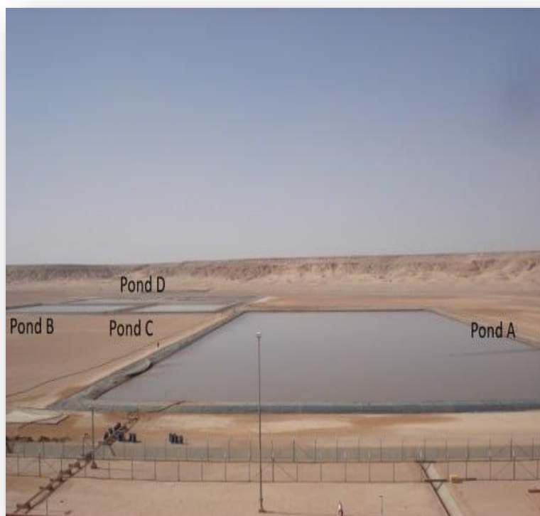
Figure II.10 : Vue réelle des bassins d'évaporation
