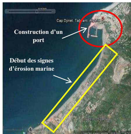
Figure 5b. Construction d'un port de pêche
