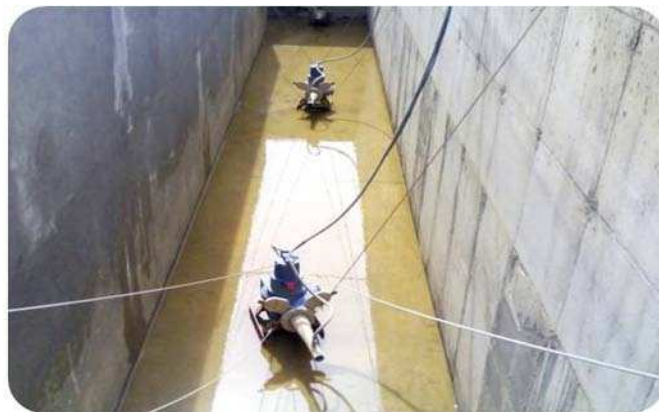
Figure (11): Système d'aération photo ondpa (Aber, 2010)
