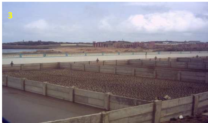
Photos 1-2-3. Bassin biologique, Clarificateur, Lits de séchage.
