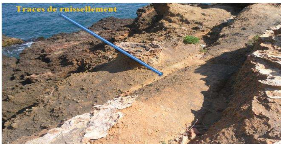
Photo 3: Trajectoire des eaux de pluie sur la tirasse de la falaise (Avril 2012)
