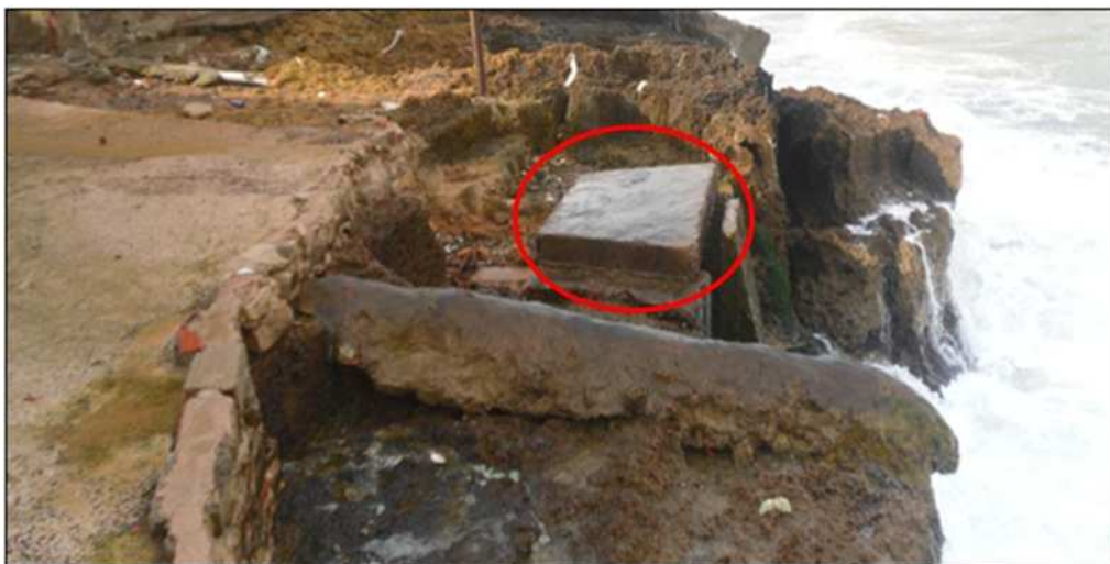
Photo 5: Installation des égouts sur la falaise (Avril 2012)
