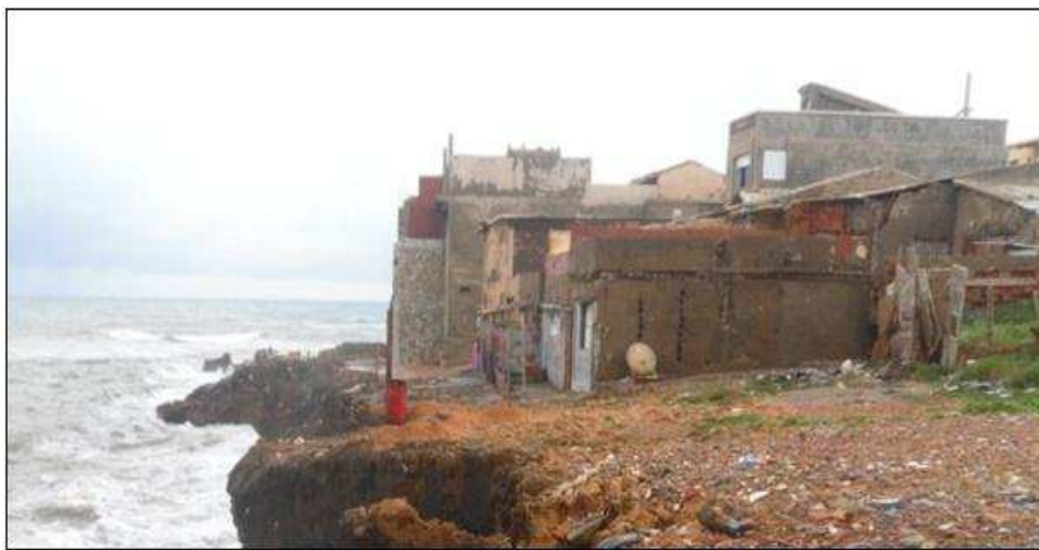
Photo 4: construction d'habitations sur le rivage (Mars 2012)
