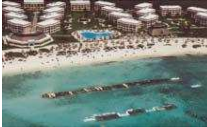
Figure 27: Système TenCateGeotube® installé en mer comme brise-lames (Italie)
