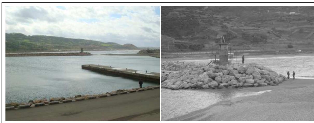
Photo n°1.2 & 1.3 Passe d'entrée du port de Cap Djinet complètement fermée (Février 2010)
