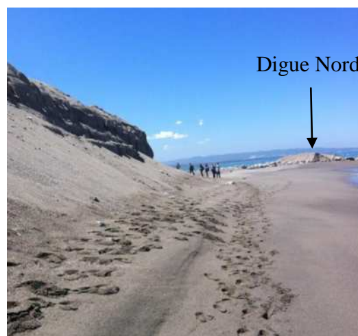
Photo n°7.3 : Accumulation massive du sable au niveau de l'épi Nord.
