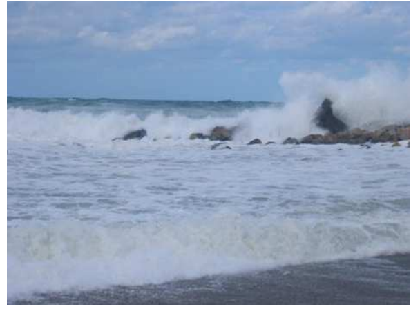
Photo n°1.6 Attaque marine de la côte de Zemmouri par les vagues de tempête.
