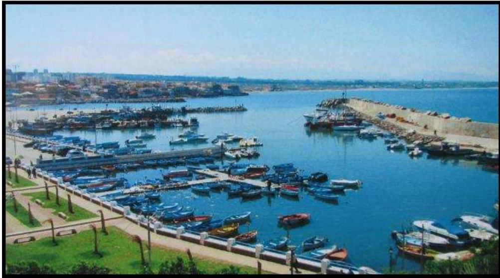
Figure I.2 : Vue générale du port d'El Djamilia
