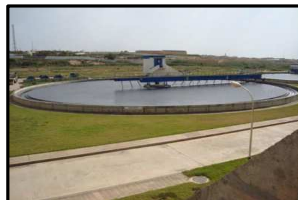
Figure 10 : Décanteur secondaire
