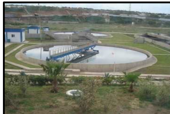
Figure 08 : Décanteur primaire
