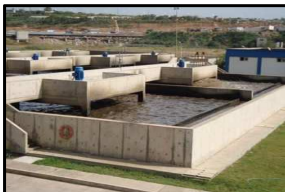
Figure 09 : bassin d'aération
