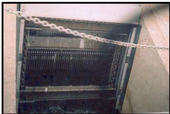
Figure 05 : dégrillage grossier
