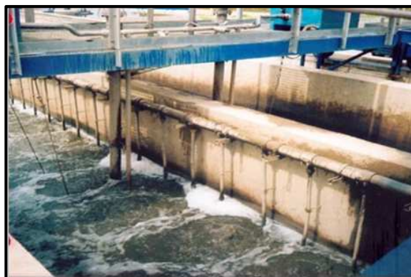
Figure 07 : Dessablage-déshuilage
