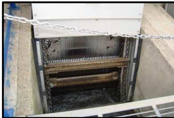
Figure 06 : Dégrillage fin
