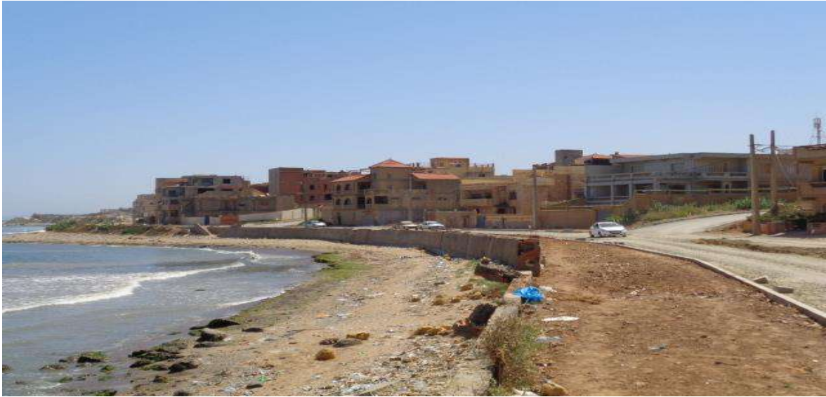
Figure IV.3 : Constructions en cours de réalisation longeant la côte de Bou Ismail.
