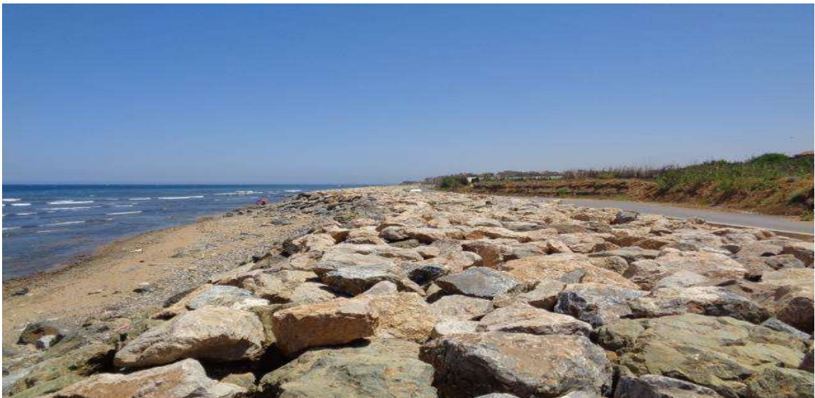
Figure II.2 : Enrochement naturel longeant une partie de la côte de Bou Ismail.
