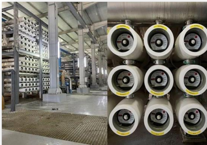
Figure 2.16: Les racks des membranes(Madoui, 2023)
