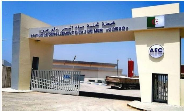
Figure 2.1: la station de dessalement de Les principales entreprises impliquées dans la réalisation et l'exploitation de cette station sont présentées ci-après :
