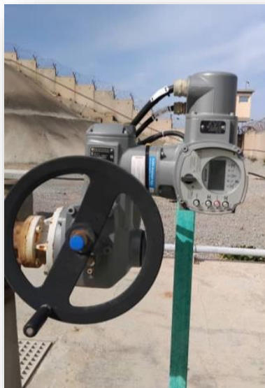
Figure 2.6: vanne d'isolement(Madoui, 2023)
