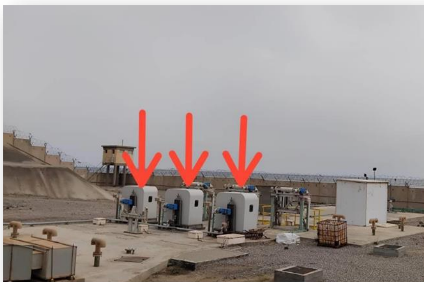
Figure 2.8: tamiseur à bande mobile(Madoui, 2023)
