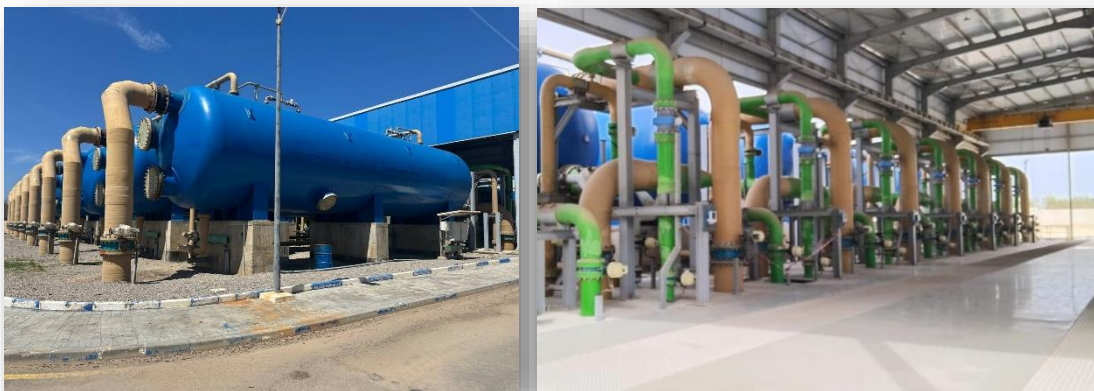
Figure 2.13: Les filtres à sable
