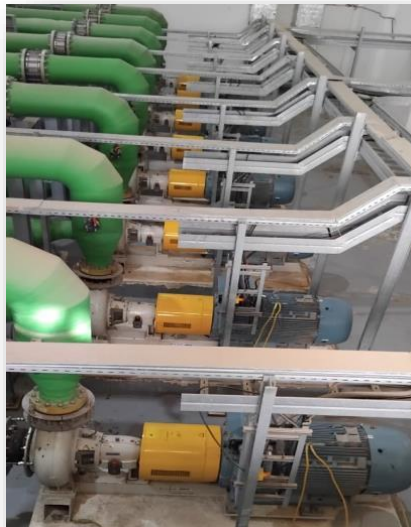
Figure 2.12: Les pompes intermédiaires(Madouï, 2023)
