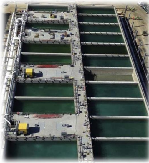
Figure 1.4: Les filtres gravitaires (Kadouche et al., 2018)
