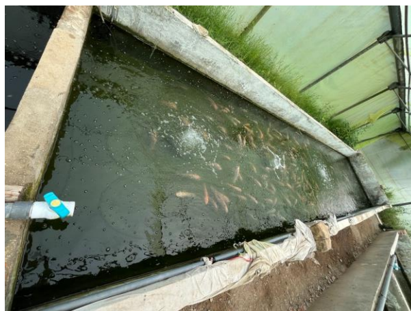
Figure 46 Bassin d'isolement et de traitement .
