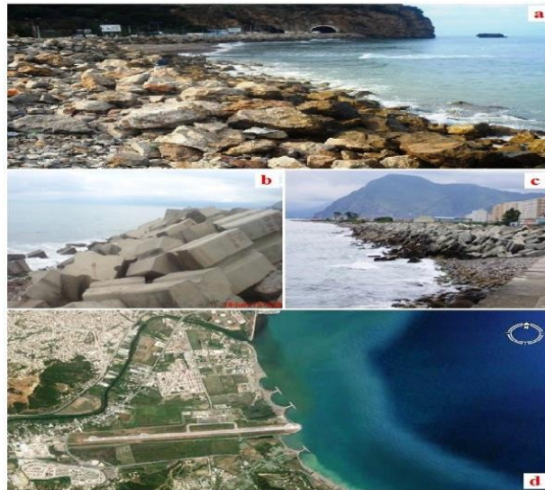
Figure 8 : Ouvrages de protection implantés le long du rivage du golfe de Bejaïa.
