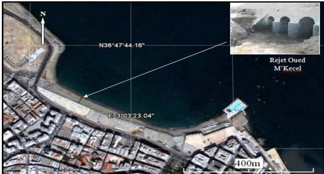
Figure 2: Localisation du grand collecteur de Oued M'Kecel « 1 ère sortie » (Google earth, 2009)
