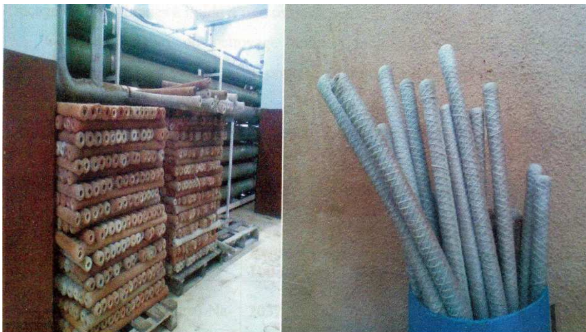
Figure 15 : les membranes des modules d'osmose inverse
