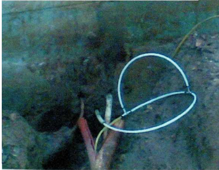
Figure 7 : l'injection des produits chimiques dans le tuyau de mélangeur.
