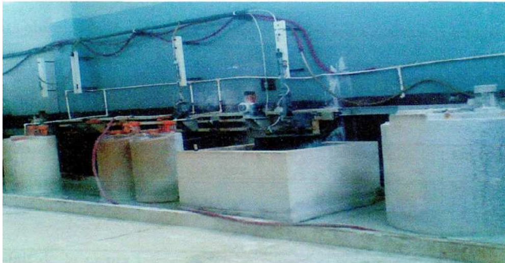
Figure 18 : poste de préparation des produits chimiques.
