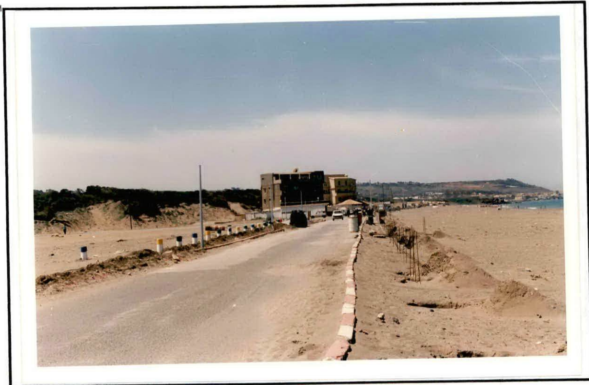
Photo n° 5 : Occupation du linéaire côtier - Infrastructures hôtelière et kiosques. - Piste en bordure de la côte. - Construction d'un mûr en chantier.
