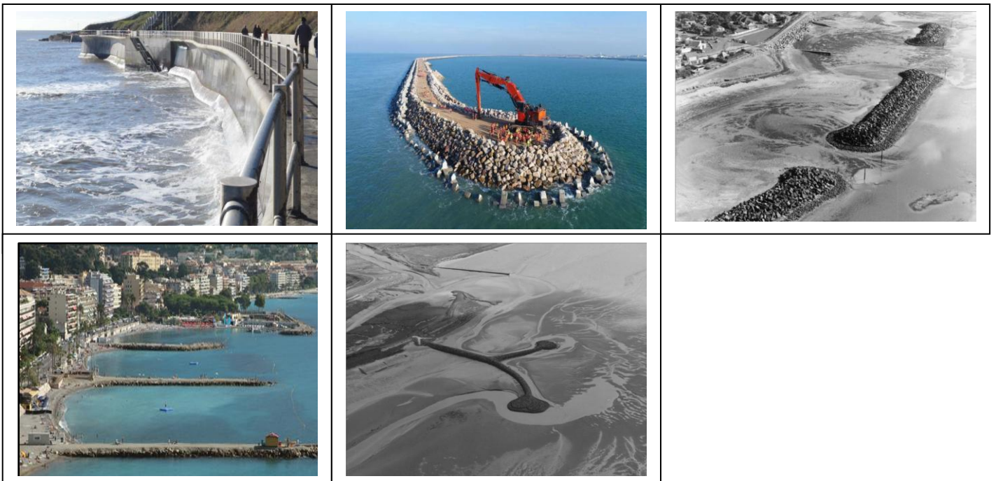
Figure7 : Exemple d'ouvrages de protection du littoral : un mur côtier, une digue, un brise-lame, des épis. (Respectueusement
