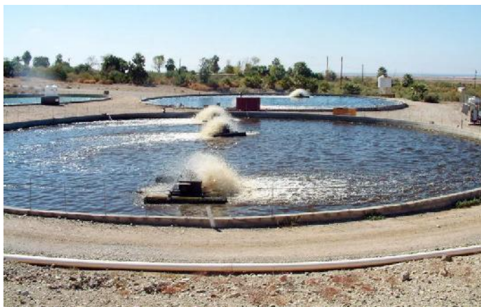
Figure 15. Système d'aération dans un bassin du tilapia en BFT (Avnimelech, 2011)
