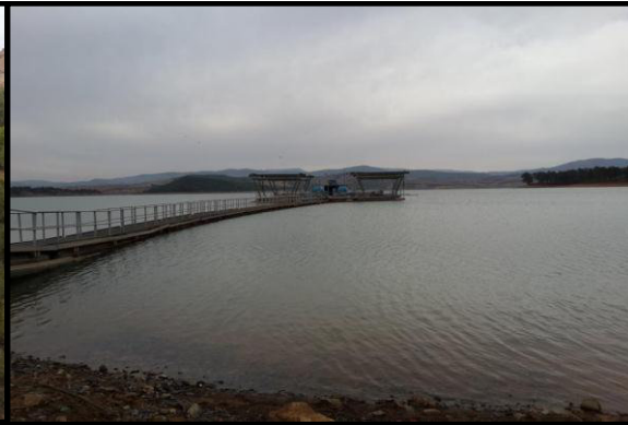
Figure 29 : Barrage Sidi M'hammed Bentaiba.
