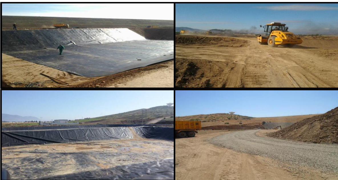
Figure 18 : Les travaux au niveau de la ferme Harreza.
